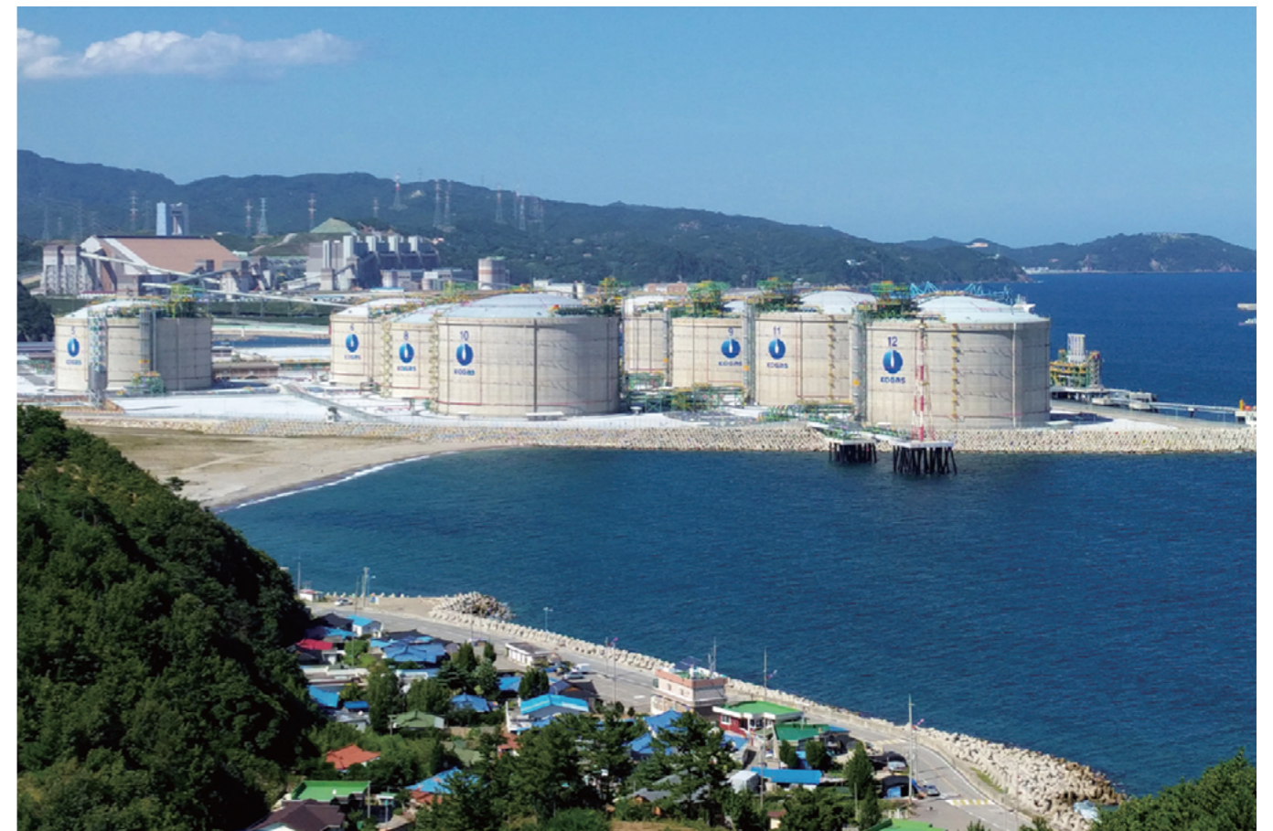
삼척 LNG 저장탱크 및 부대설비
