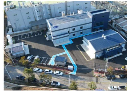
(주)유피케미칼 3공장 Precursor Plant 신축
