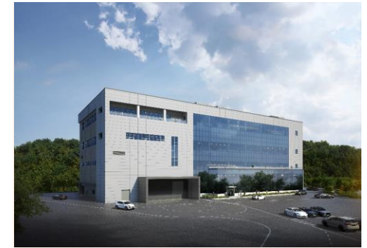
(주)테스 연구동 신축 Project
