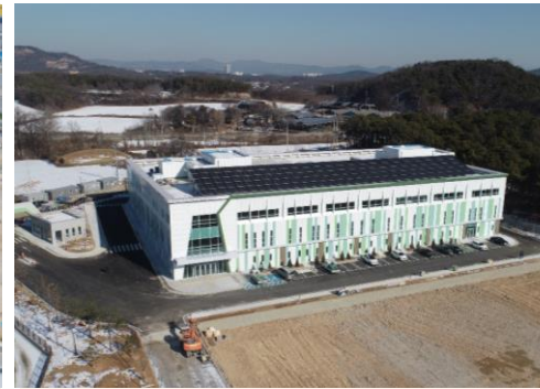
(주)고영테크놀러지 생산센터 신축 Project
