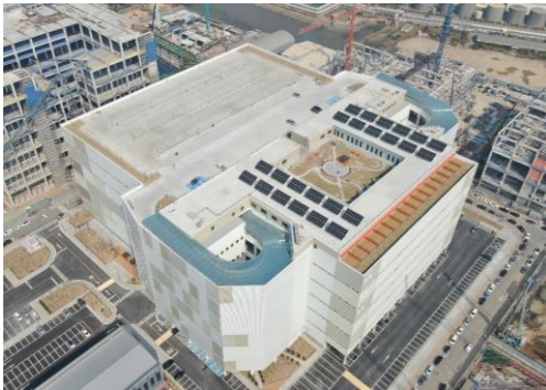
남청라 스마트로지스틱스 신축 Project
