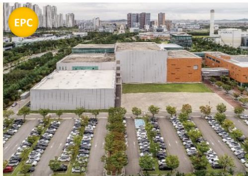
셀트리온 2공장 물류동 증축 Project
