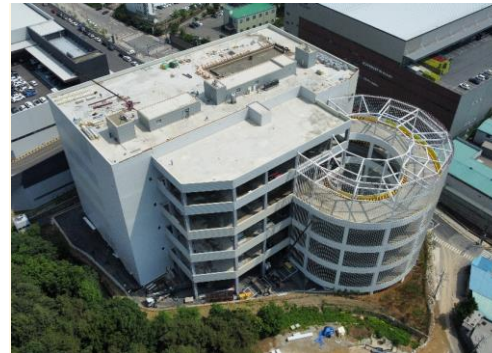
아미산업(주) 용인 물류센터 신축 Project
