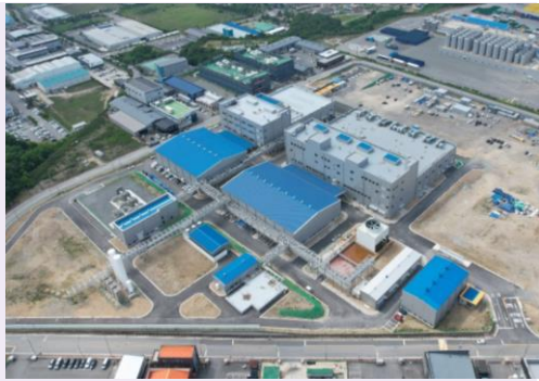
재세에너지 총주공장 부지정지 Project
