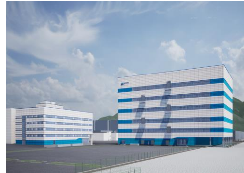
해성디에스 사무동, 제조동 신축 Project
