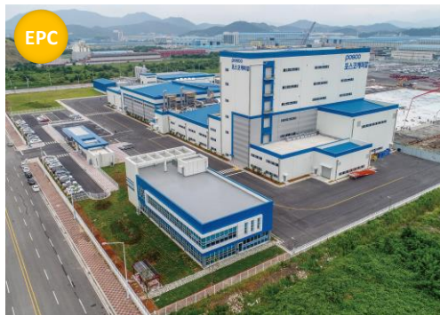
포스코ESM 광양아차전지양극재 신축Project
