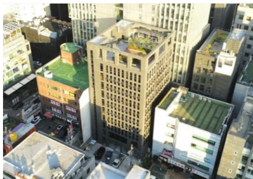
강남 삼오빌딩 철거 및 신축 Project
