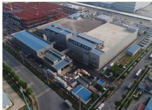
하나마이크론 비나 2LINE 증축 Project
