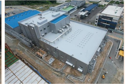
1.8만톤 하이 니켈 양극재 신 라인 건설 Project (1-1기)
