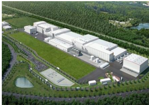
SK Battery America LIB 공장 신축
