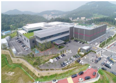
(주)엘오티베콤 오산통합사옥 신축 Project
