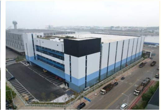
슈피겐코리아 인천 물류센터 신축 Project
