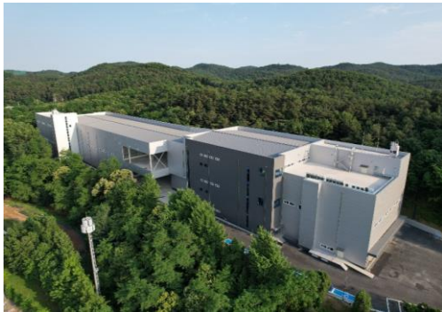
해성산업 동탄물류센터 신축 Project
