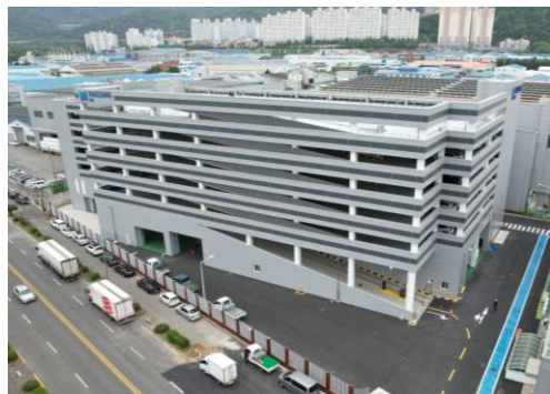
해성디에스 주차빌딩 신축
