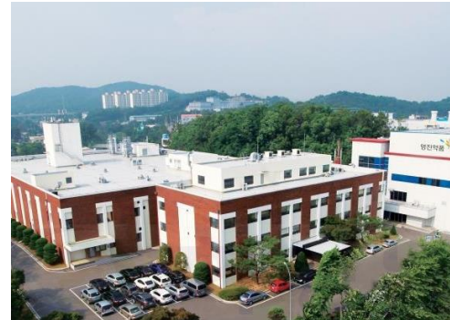
화성 영진바이오 일반산업단지 조성 Project
