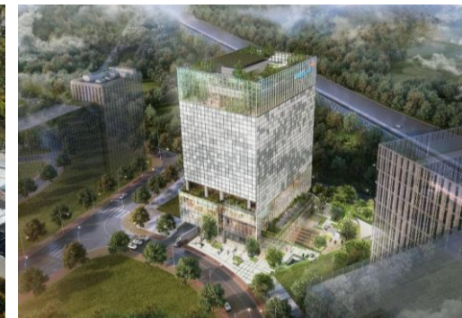
판교 제2테크노밸리 신축 Project
