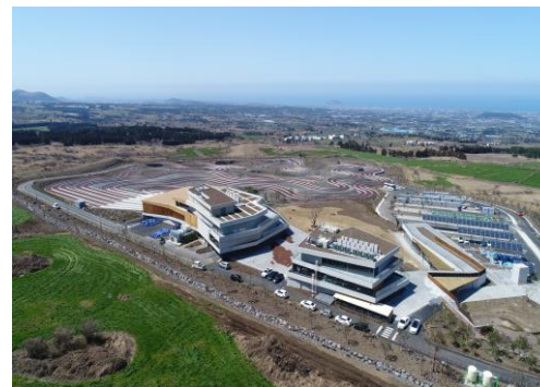
제주 9.81park 신축 Project
