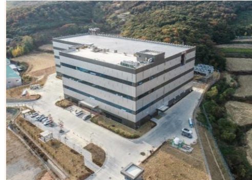
(주)테스나 안성 신축 Project
