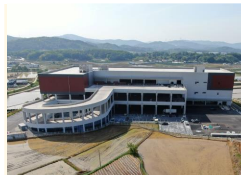
코스모스로지스 안성 물류센터 신축 Project
