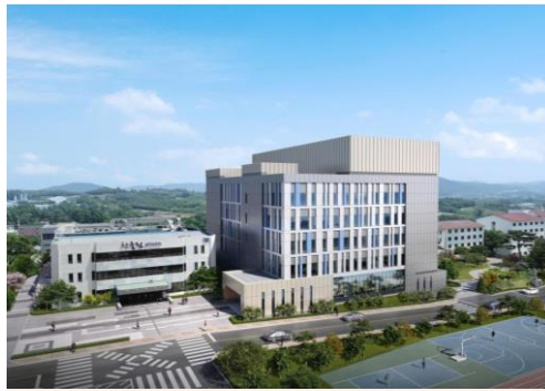
삼성전기 세종복합동 신축공사
