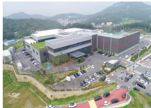
(주)엘오티베콤 오산통합사옥 신축 Project
