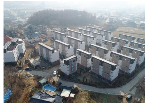
천안 유량동 도시형 생활주택 개발 Project
