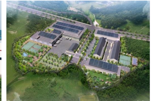
오산 세마일반산업단지 조성 Project
