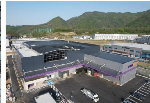
퍼플랜드 증평공장 신축 Project
