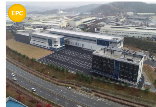
무진전자 안성 신축 Project
