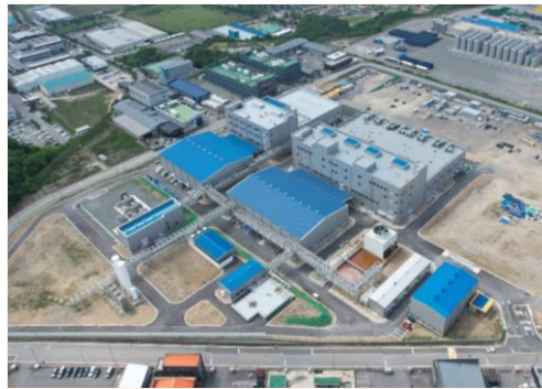
1.8만톤 하이 니켈 양극재 신 라인 건설 Project (1-2기)
