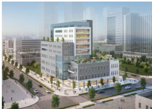
빅텍-에이스웨이브텍 송도 사옥 신축 Project
