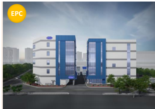
유피케미칼 제2공장 9동 증축 Project
