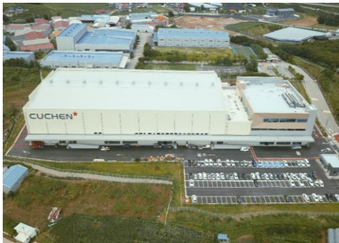
(주)쿠첸 천안사업장 이전 및 신축 Project
