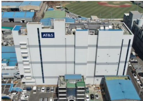
AT&S KOREA FPCB공장 증축 Project
