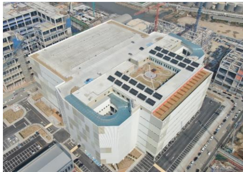
남청라 스마트로지스틱스 신축 Project
