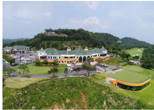
떼제베CC 청주 골프장 기숙사 Project
