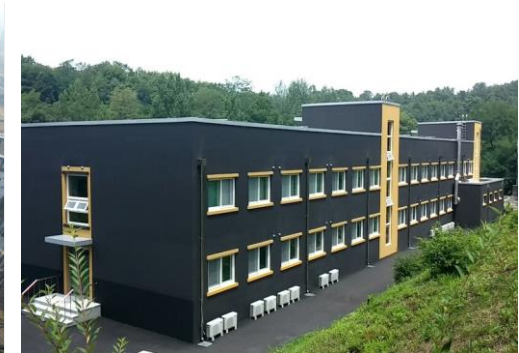
여주 신라CC 기숙사 신축 Project
