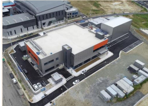
(주)그린제약 금왕 GMP 신축 Project
